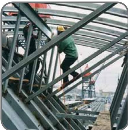
Ручная дуговая сварка до сих пор широко используется при производстве металлоконструкций, главным образом, благодаря своей универсальности. По сравнению с другими сварочными процессами, данный тип сварки предполагает использование несложного портативного и недорогого оборудования.
